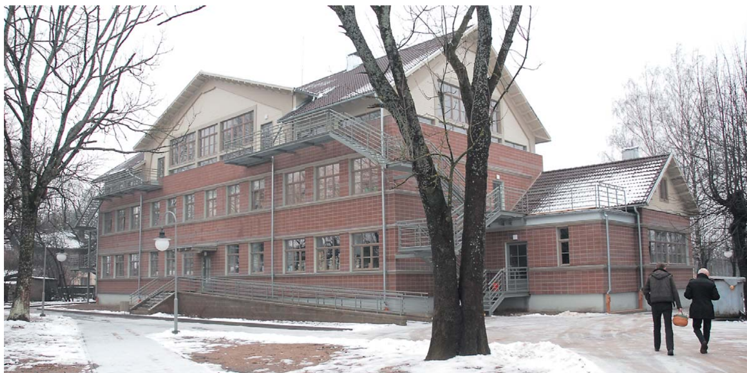
Projekta rezultātā ir uzlabota Kuldīgas Mākslas un humanitāro zinību vidusskolas infrastruktūra, veicot skolas telpu rekonstrukciju Pētera ielā 10, kā arī uzbūvējot 3. stāvu.
