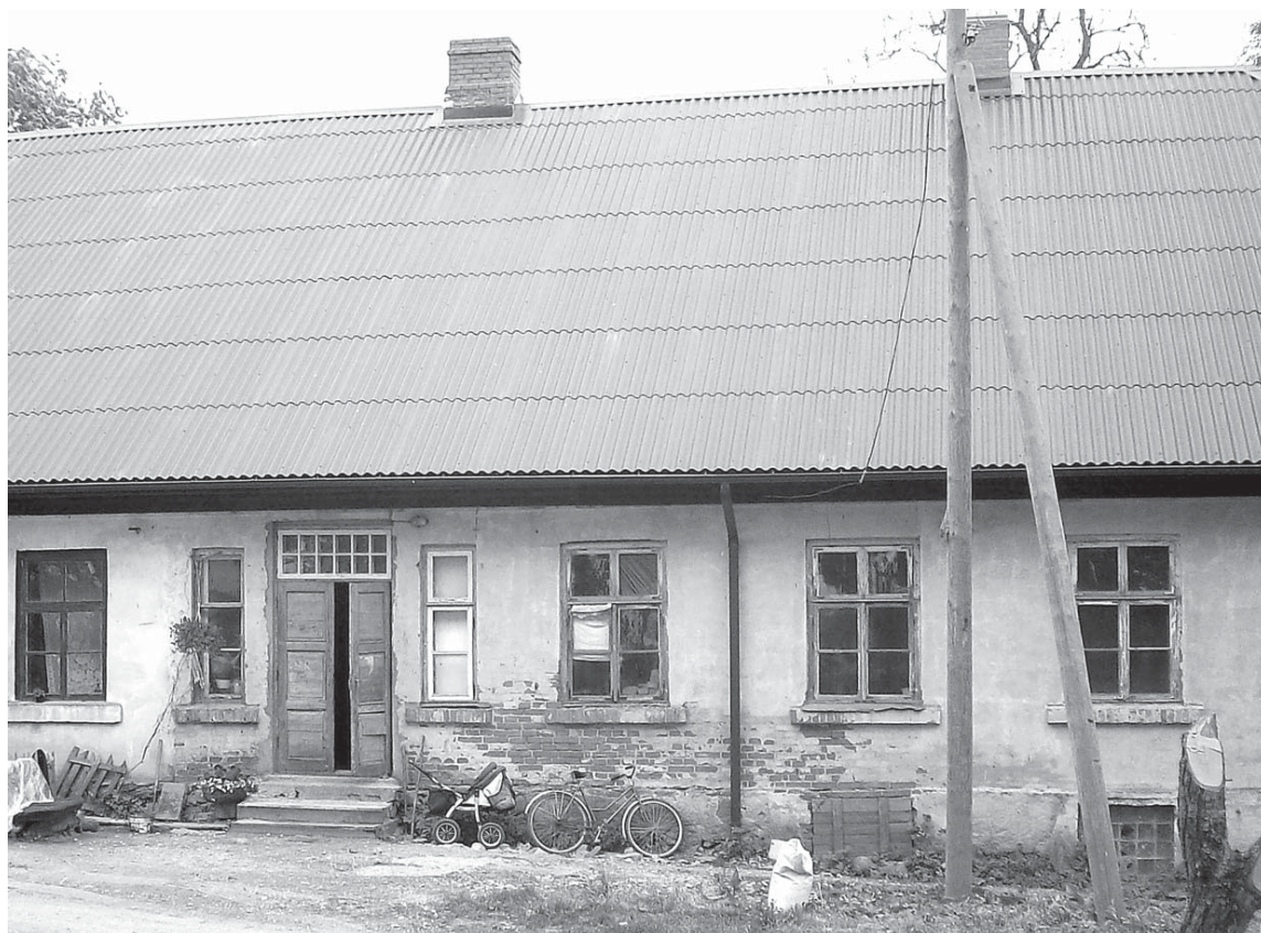
„Mazīvandes” Īvandes pagastā ir viena no deviņām sociālajām dzīvojamajām pašvaldības ēkām, kuru iecerēts siltināt, lai uzlabotu sociāli maznodrošināto un mazaizsargāto grupu iedzīvotāju dzīves apstākļus.
