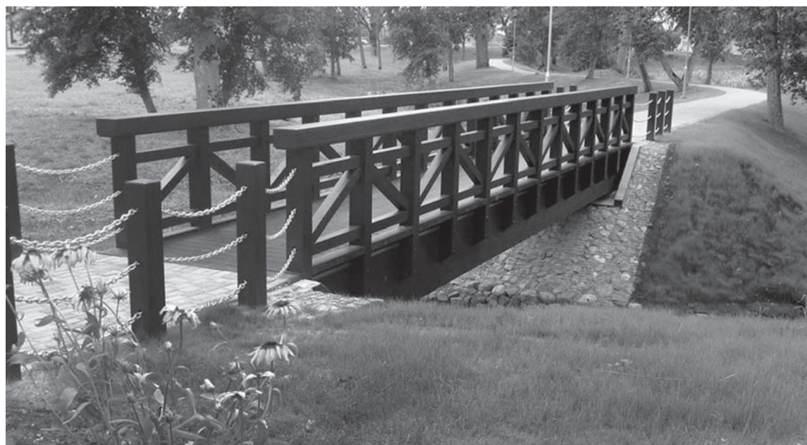
Padurnieki priecājas par centrā izbūvēto tiltu un gājēju celiņu, jo vairs nav jāpārvietojas pa autoceļa malu.
