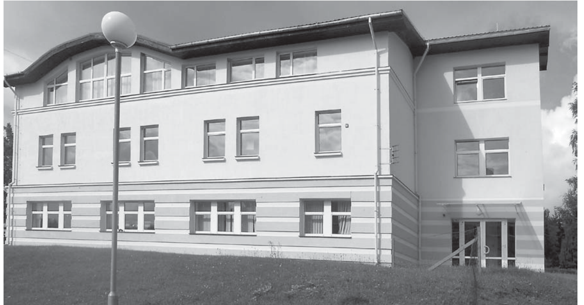
Pelču speciālās internātpamatskolas-attīstības centra renovētajā ēkā tagad ir lifts, kas atvieglos pārvietošanos audzēkņiem ar īpašām vajadzībām.
