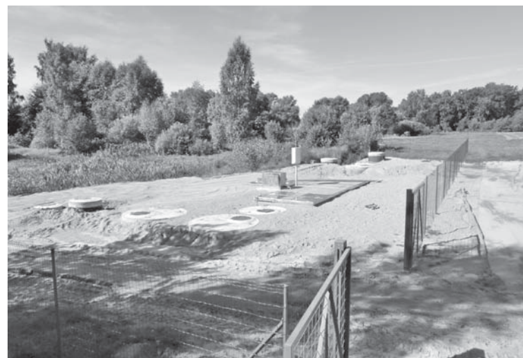
Notekūdeņu attīrīšanas iekārtu teritorija Snēpelē pirms un pēc rekonstrukcijas.
