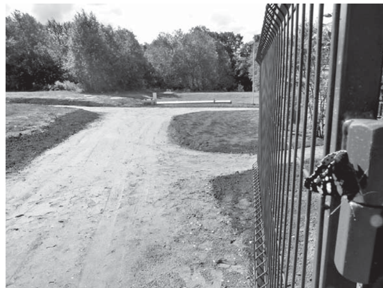
Notekūdeņu attīrīšanas iekārtu teritorija Ēdolē pirms un pēc būvdarbiem.
