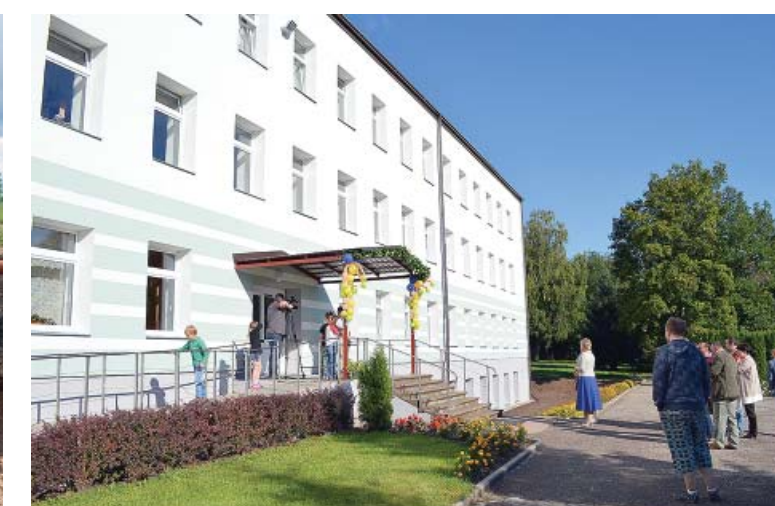
Pelču speciālajā internātskolā-attīstības centrā veikti vērīnīgi būvdarbi – nosiltināta ēka, uzstādīta ventilācijas sistēma un nomainīts anaizsmojuums.
