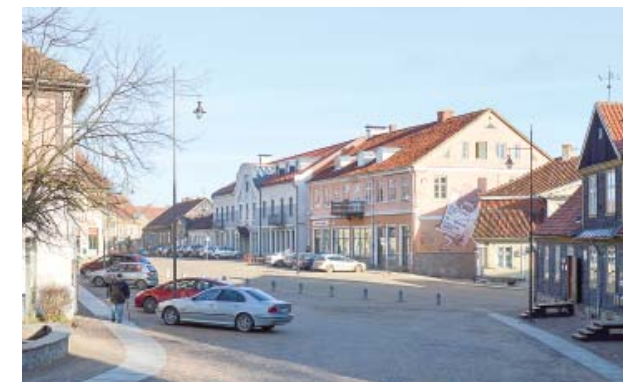
Kuldīgas „Venēcijas” projektā pilsēta atguvusi savu vēsturisko veidolu – pazemināts ielu līmenis un izveidots šķēltā bruģa segums, iekārtoti apstādījumi.
