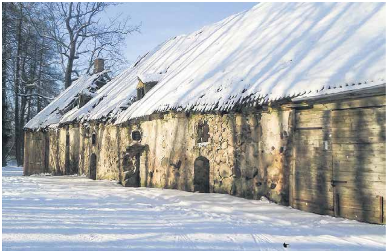
Par pašvaldības līdzekļiem turpinās iekonservēt veco klēti Vārmē.
