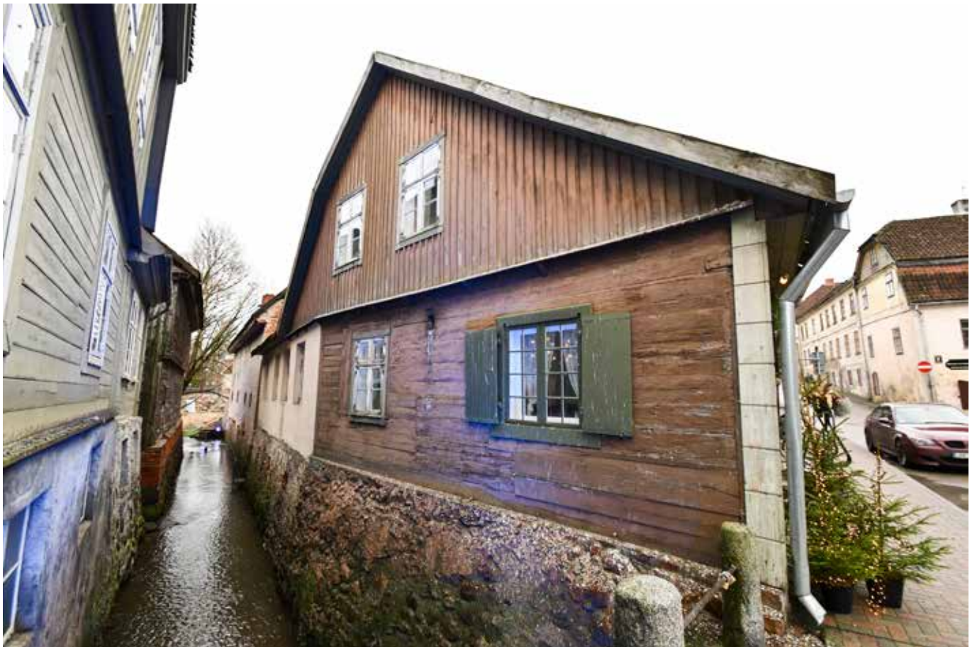
59. attēls. Ēka Pasta ielā 5. Ričarda Sotaka foto, 2020.
