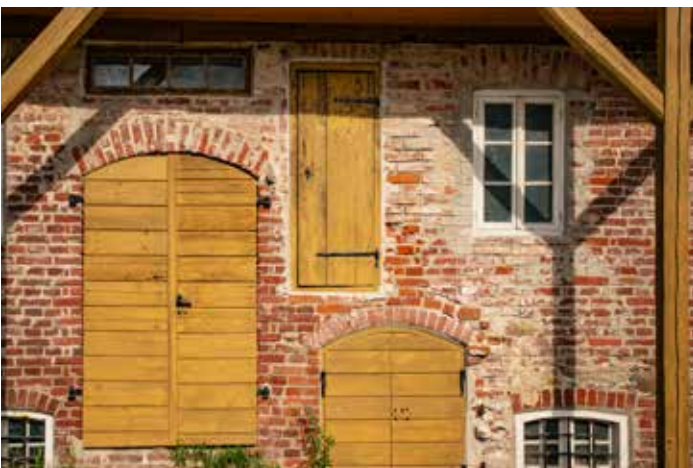
135. attēls. Palīgēkā Liepājas ielā 3A saskatāma pieaugoša tendence izmantot ķieģeļus komerciālu ēku būvniecībā. Krista Spruksta foto, 2020.
