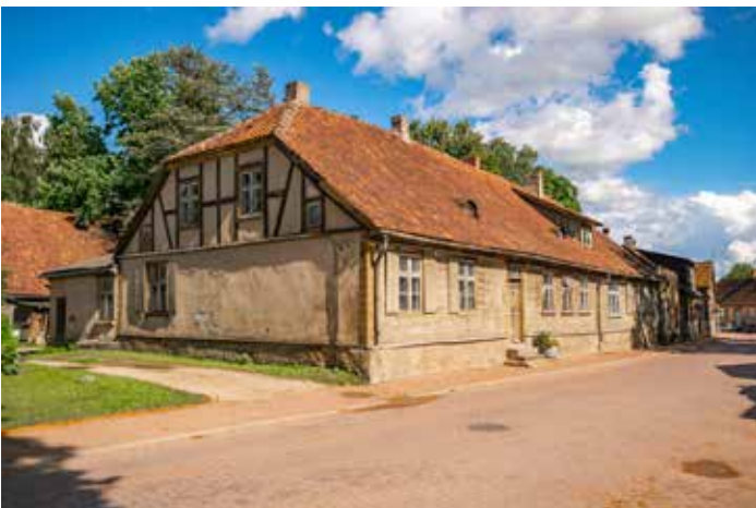
134. attēls. Ēka Ventspils ielā 23 demonstrē tradicionālās koka arhitektūras apvienojumu ar starptautiskajām ietekmēm, ko iezīmē pildrežģa koka konstrukcija. Krista Spruksta foto, 2020.
