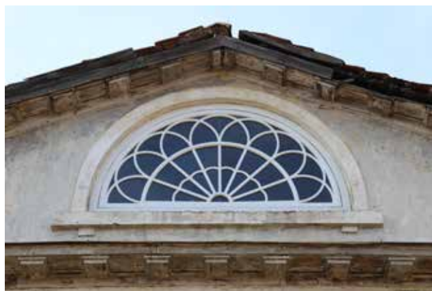
198. attēls. Frontona logs Baznīcas ielā 14 pirms un pēc restaurācijas. To atjaunoja ar tradicionālām metodēm un atbilstošiem tradicionāliem paraugiem. Kuldīgas novada pašvaldības arhīva foto, 2019.
