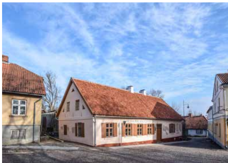
188. attēls. Restaurācijas centra ēka Baznīcas ielā 30 pirms (augšējais attēls) un pēc restaurācijas. Kuldīgas novada pašvaldības arhīva foto, 2011. Ričarda Sotaka foto, 2019.
