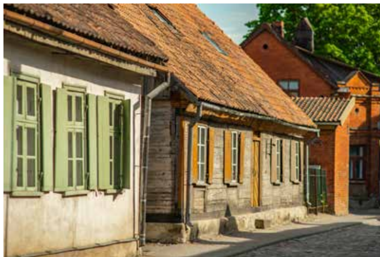
131. attēls. Ēkas Raiņa ielā demonstrē tradicionālos būvmateriālus. Ēkas Raiņa ielā 4 un 6. Krista Spruksta foto, 2020.
