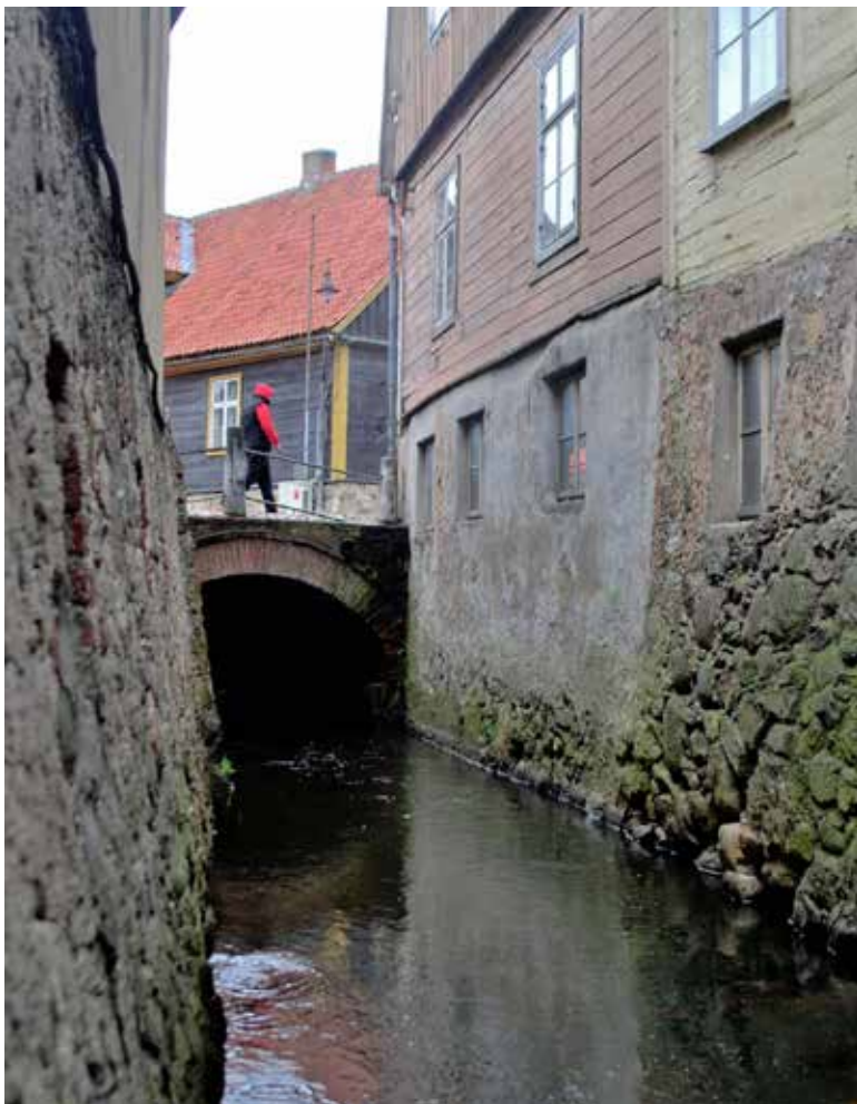
30. attēls. Pasta ielas tilts pāri Alekšupītei – sākotnējās konstrukcijas datējamas ar 17. gadsimtu. Kuldīgas novada pašvaldības arhīva foto, 2005.
