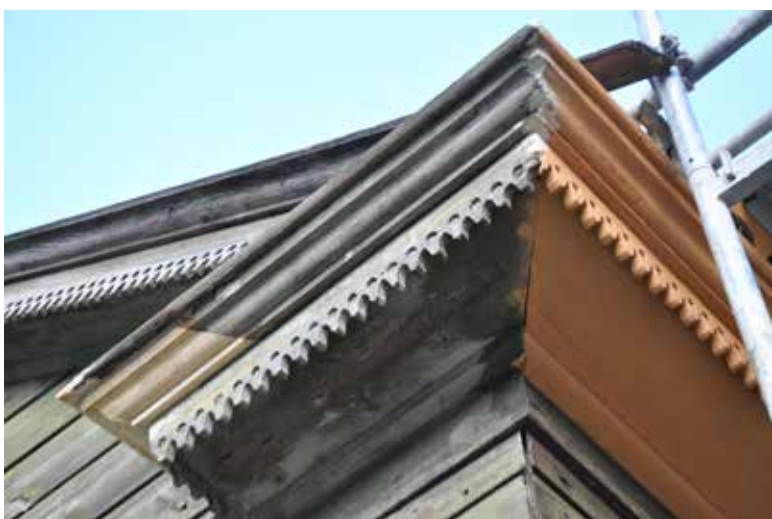
177. attēls. Skārda notekrenes, lāseņi, dzega ēkas restaurācijā 1905. gada ielā 12. Intas Jansones foto, 2011.
