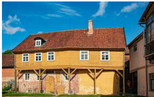
202. attēls. Ēka Liepājas ielā 3A. Krista Spruksta foto, 2020.
