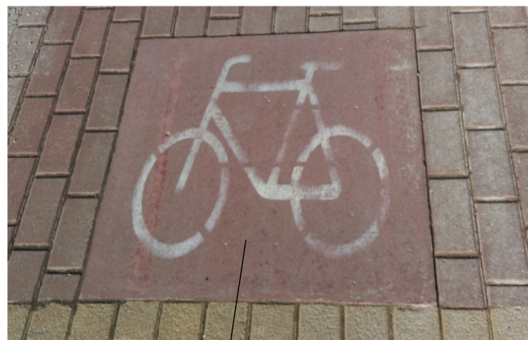
Veloceliņu apzīmē ar betona plāksni 80x80, sarkana
