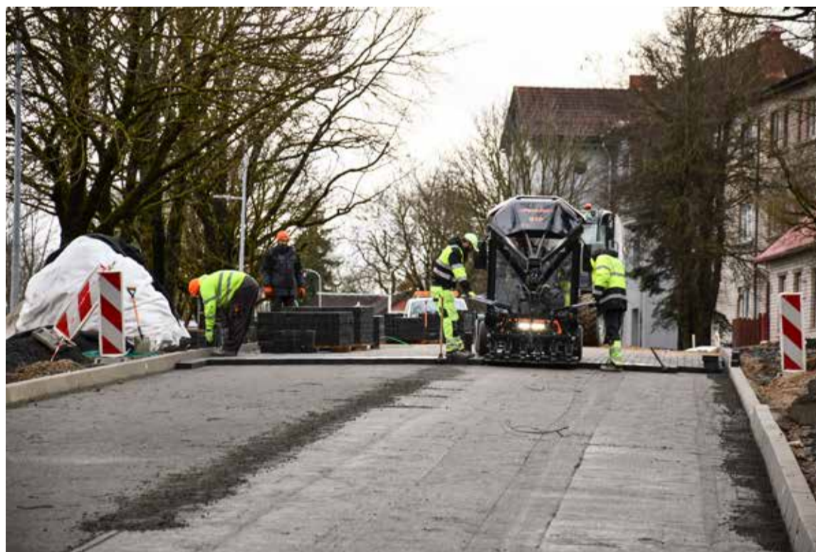
Virkas ielā notiek ceļa seguma ieklāšanas darbi.
